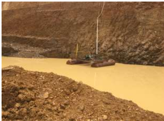
Foto 03. Ponto do rebaixamento
