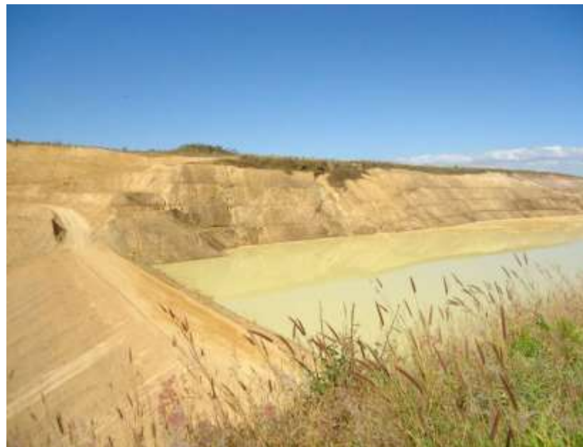
Figura 4: Vista parcial da Barragem de Rejeitos.
