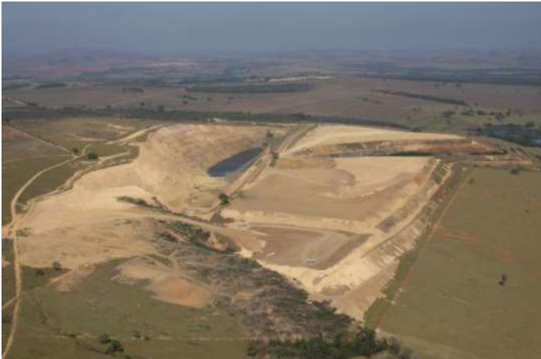
Figura 3: Vista parcial da pilha de Rejeito/Estéril.
