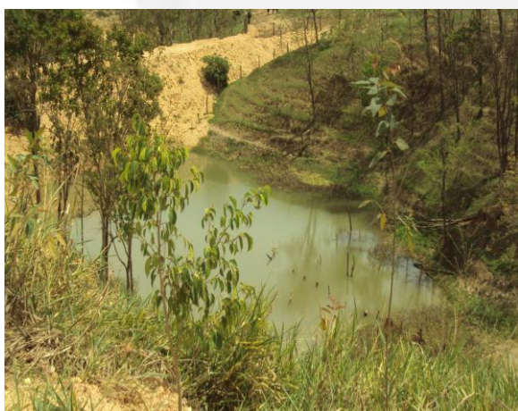
Foto 7: Local de armazenamento de água pluvial
