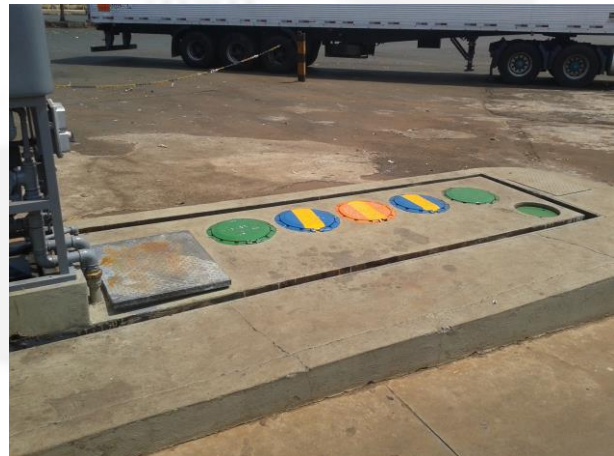
Foto 04. Descarga a distância e filtro de diesel
