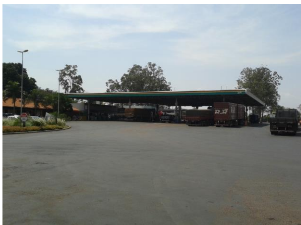
Foto 05. Pista de abastecimento de caminhões
