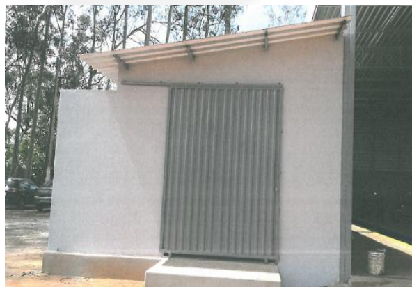
Foto 07. Deposito de resíduos
