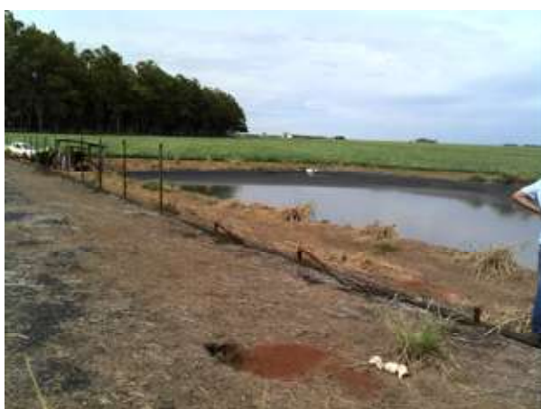
Figura 19. Lagoa de estabilização
