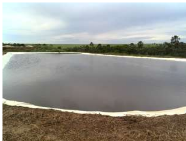
Figura 18. Lagoa de estabilização
