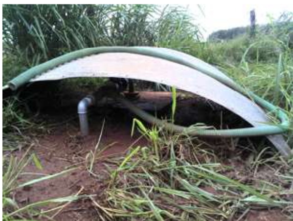
Figura 22. Poço tubular
