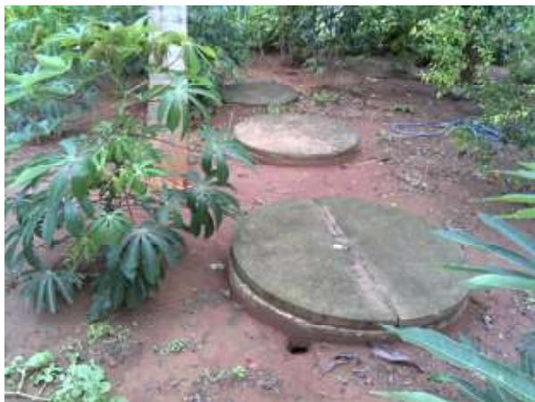
Figura 11. Fossa séptica seguida de sumidouro
