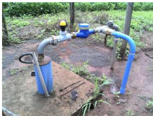
Figura 23. Poço tubular
