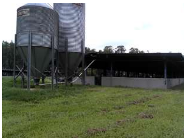
Figura 01. Galpão de suínos
