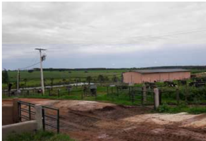
Figura 06. Vista do galpão de silagem e barramento
