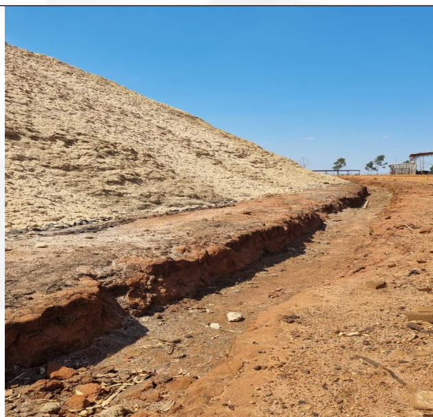
2- Canaletas sem impermeabilização.
