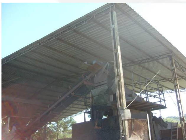
Foto 09. Aspersor de água no processamento
