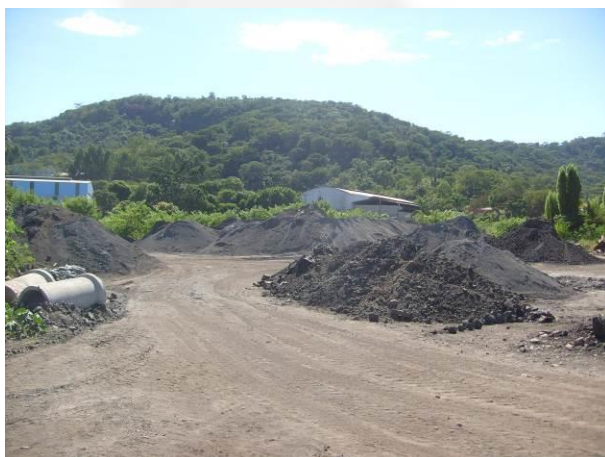
Foto 03. Pátio de recebimento
