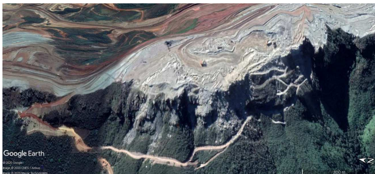
Figura 3: Avanço da cava em direção à face oeste.
