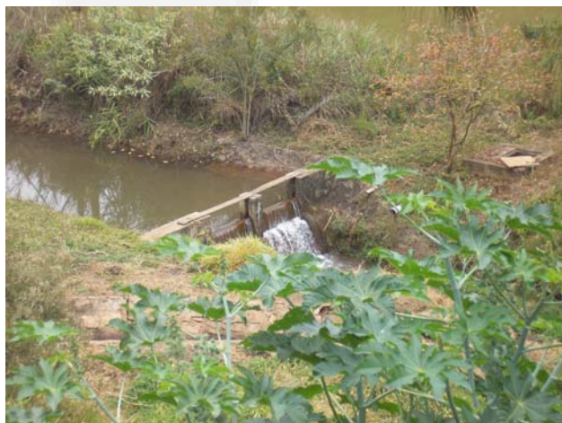
Foto 03. Barramento localizado no córrego Mandembo
