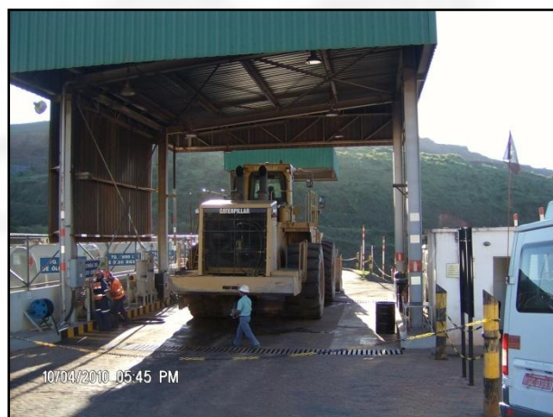
Foto 04. Posto de abastecimento.
