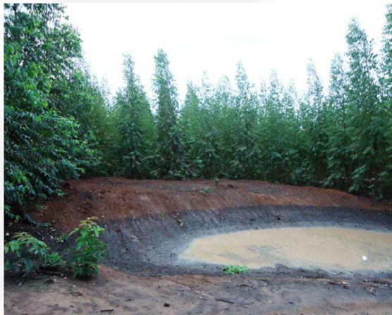
Foto 07. Bacia de contenção de águas pluviais, em estrada interna.
