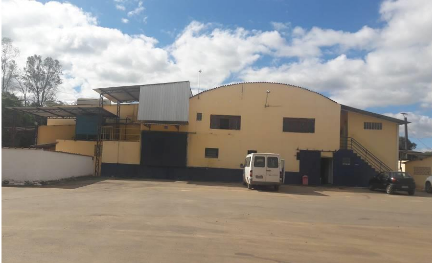
Foto 01. Vista frontal do Frigorífico
