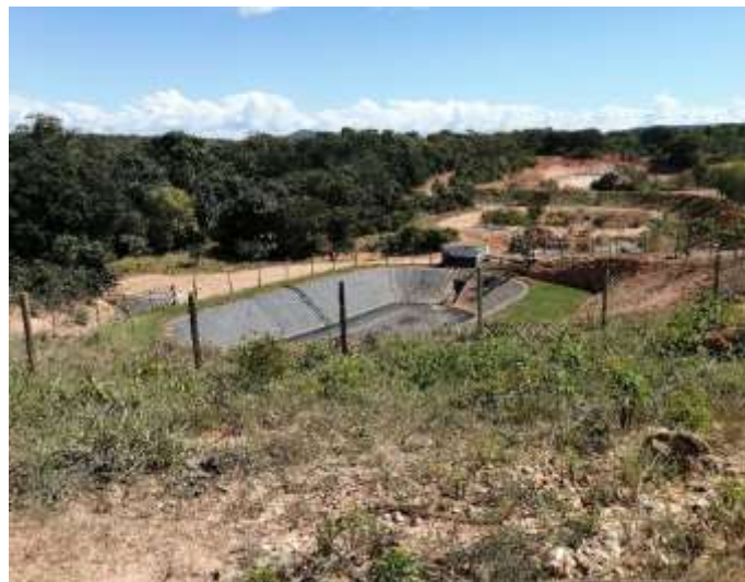
Foto 4: Lagoa de Acumulação e Bombeamento de Chorume
