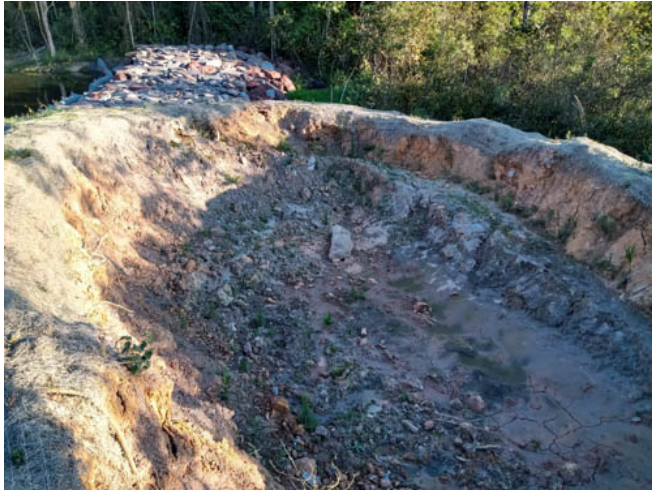
Imagem 3: Estrutura para a deposição de sedimentos.
