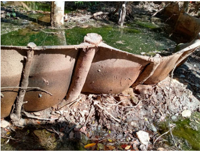
Imagem 5: Antigas estruturas de contenção de sedimentos.
