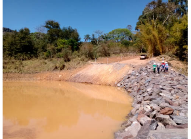
Imagem 2: Intervenções emergenciais para a contenção de sedimentos.
