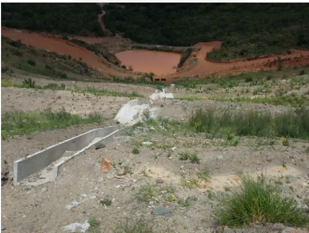
Foto 03 – Vista do Dique de Finos
