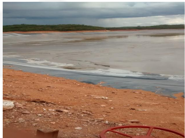
Foto 04 – Vista da Barragem de Rejeitos
