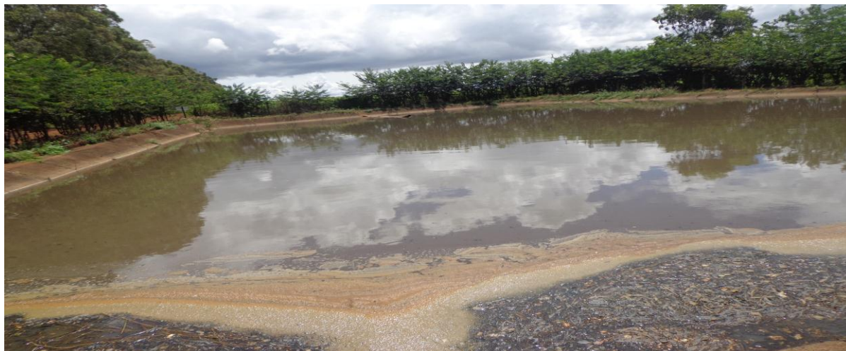
Figura 03 – Lagoa de tratamento de efluentes sanitários
