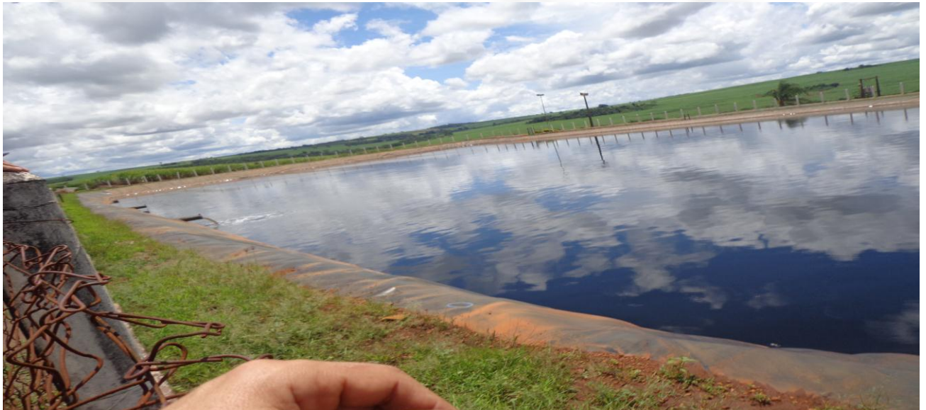
Figura 02 – Tanque de vinhaça impermeabilizado
