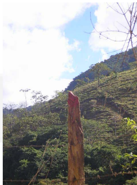
Foto 02. Marco de passagem da Torre 27, município de Açucena, no sentido da Subestação de Engenheiro Caldas
