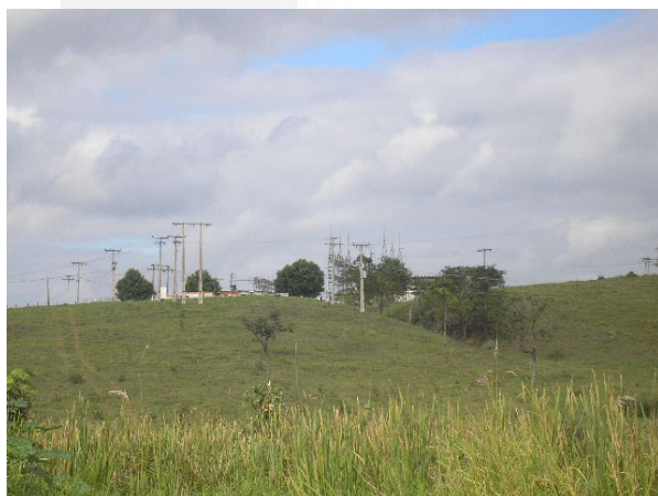
Foto 03. Vista da área de chegada na Subestação de Engenheiro Caldas
