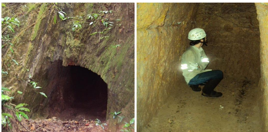
Figura 1 – Fotos da galeria de mineração identificada
