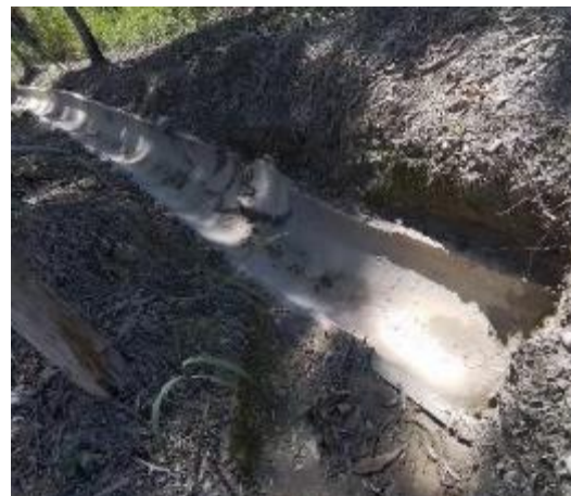
Foto 06. Canaletas drenagem pluvial.
