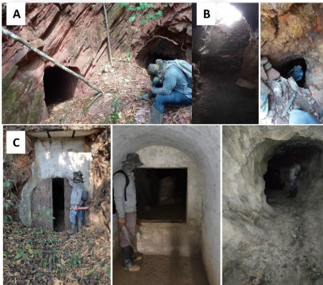
Figura 3.5: A) Entradas das Galerias 07 e 08, com seções entalhadas, discordantes das camadas rochosas; B) Galeria 05, com entrada triangular e muro de pedras; C) Galeria 04 com portão de metal e estrutura de alvenaria em sua entrada. Fonte: SEI nº 38696554.
