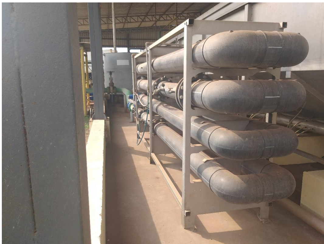
Det. do circuito criado com tubos de PVC para proporcionar a mistura dos dois produtos no efluente da linha vermelha
