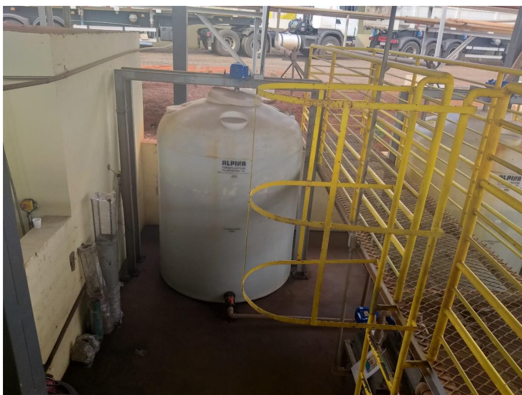
Det. do circuito criado com tubos de PVC para proporcionar a mistura dos dois produtos no efluente da linha vermelha
