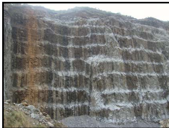
Foto 02. Local da pedreira
