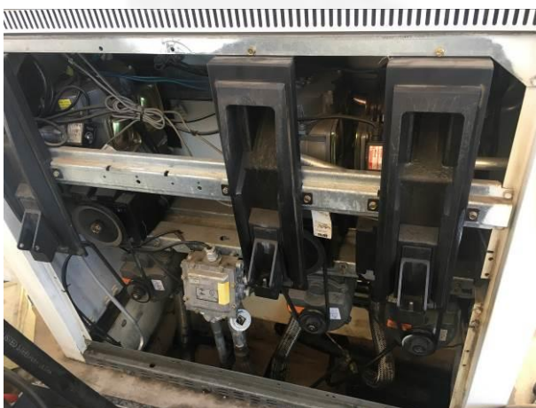
Foto 09. Bomba de combustível.
