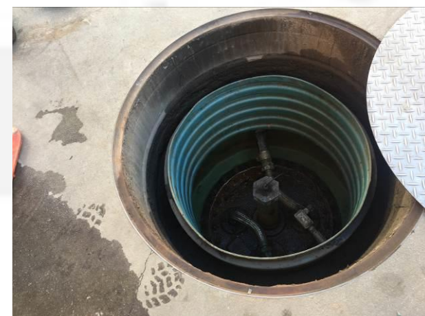
Foto 10. Boca de visita de um tanque.
