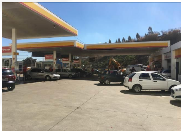
Foto 02. Visão geral do empreendimento.
