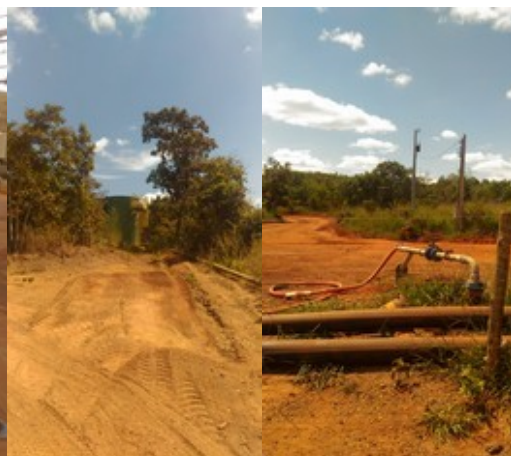
Foto 06. Poço para rebaixamento do lençol freático
