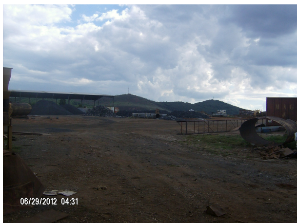
Foto 01. Vista parcial do empreendimento
