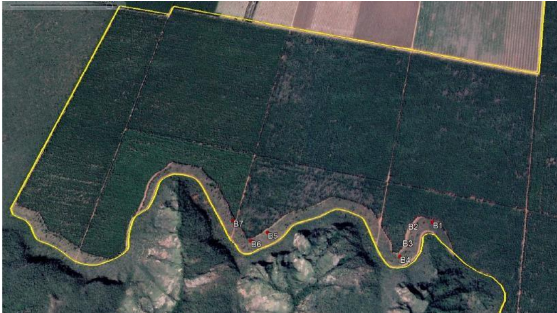
Figura 20: Localização das bacias de contenção em área de recuo de silvicultura em Área de Preservação Permanente – APP na Fazenda Espírito Santo Glebas A e B
