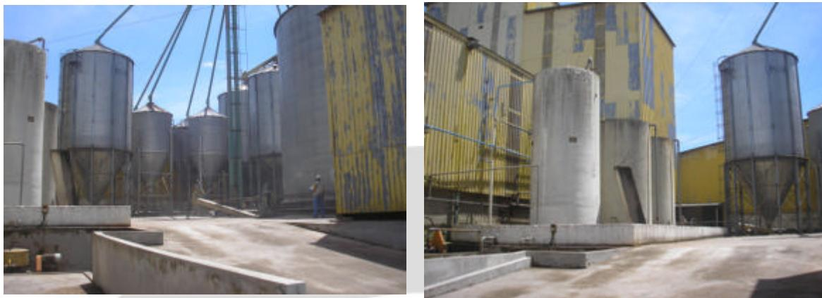
As unidades de armazenamento de produtos e insumos a granel são constituídas de uma bateria de silos, ou seja, 10 silos verticais externos, capacidade total de armazenamento - 2.744,70 m<sup>3</sup>, e 12 silos verticais internos capacidade total de armazenamento - 331,30 m<sup>3</sup>.
