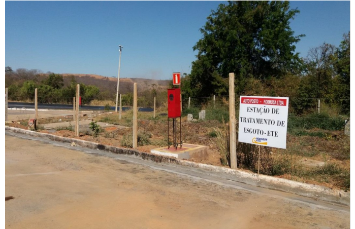
Foto 6: Área da fossa séptica, filtro anaeróbio e sumidouros
