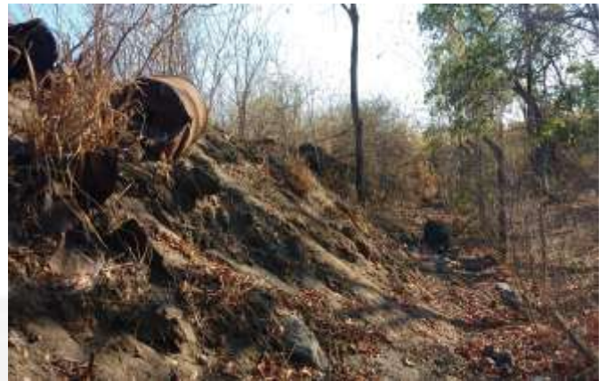
Foto 12. Área de passivo ambiental
