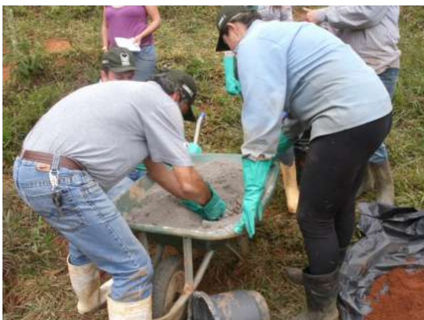
(Preparação da massa de solo cimento)
