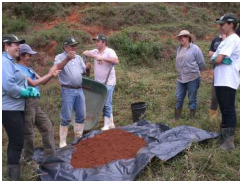
(Preparação da massa de solo cimento)
