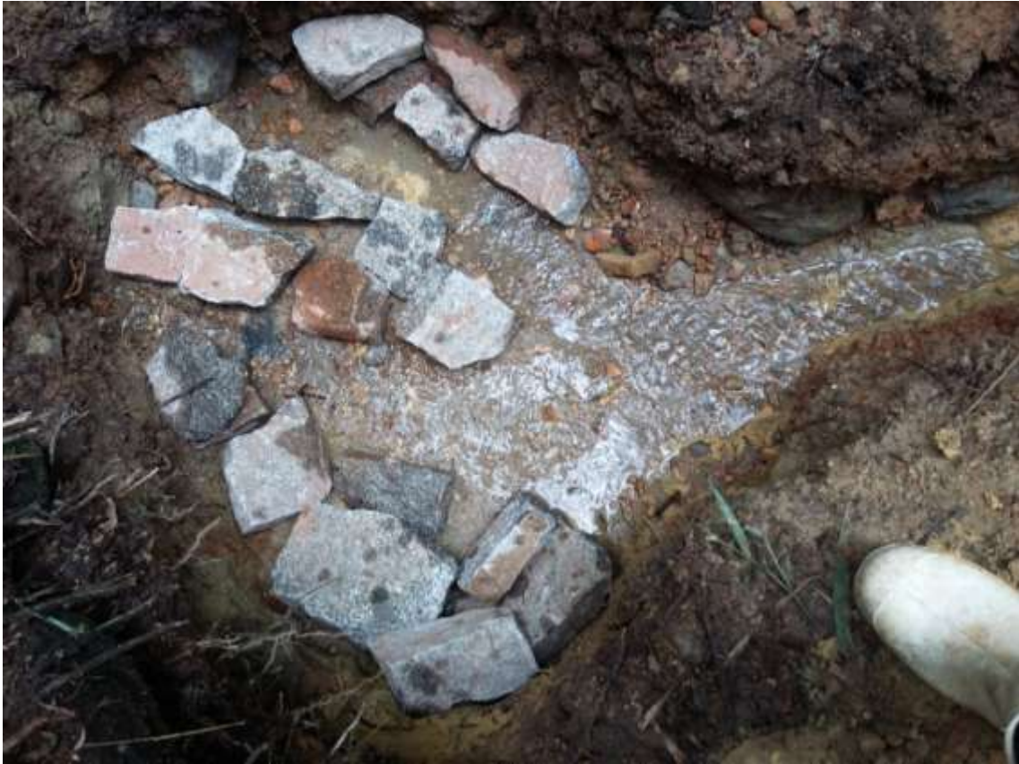
(Enrocamento feito de modo a proteger o do fluxo d'água)
