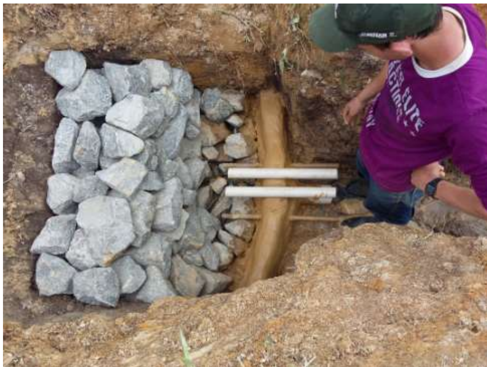
(Construção da parede e colocação dos canos)
