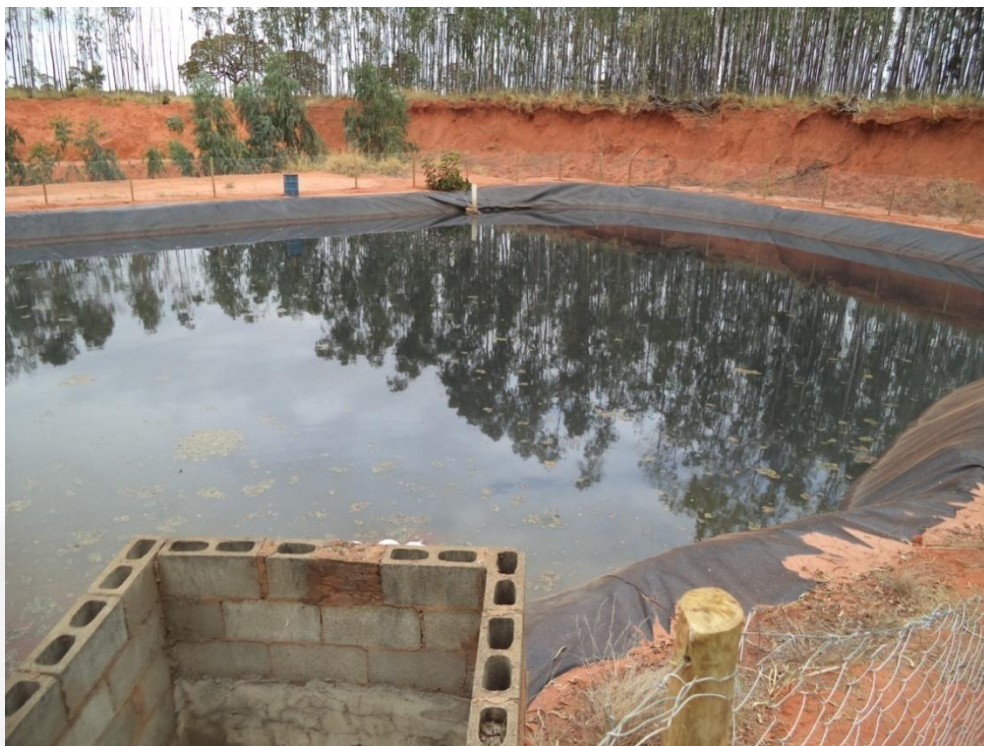
Lagoa impermeabilizada com manta PEAD para contenção de efluentes advindos das caixas separadoras de água e óleo.
