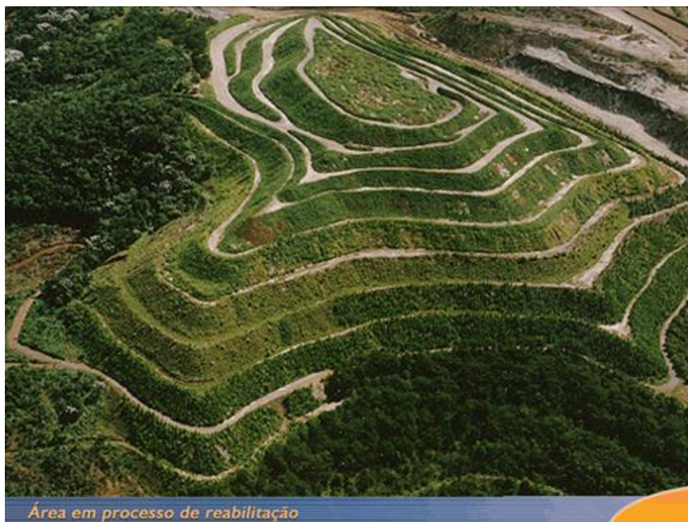
Figura 4 – Pilha de estéril em processo de reabilitação
