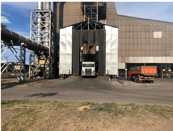
Foto 5: Galpão de Carregamento do Skip
