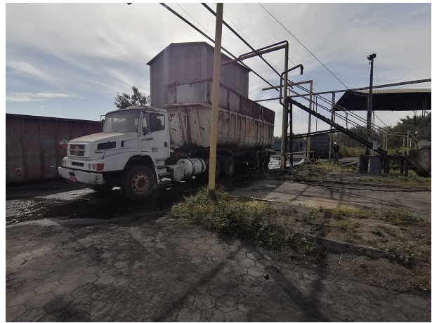
Foto 4: Despoeiramento - Descarga de Carvão
