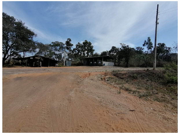
Foto 10: Galpão de Resíduos
