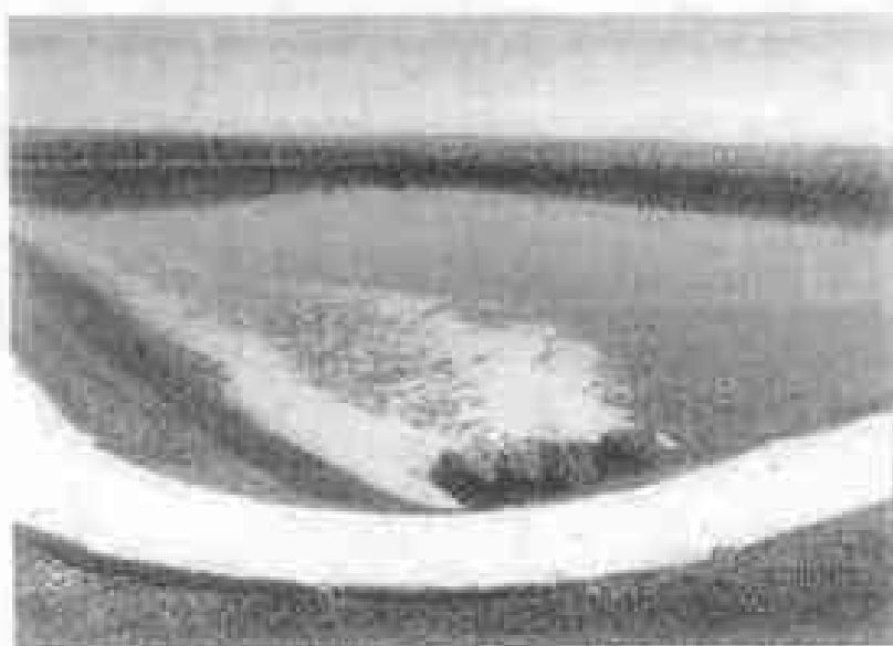
Figura 1 – Vista parcial do Reservatório Fazenda Coronel / Vinhça 10.
