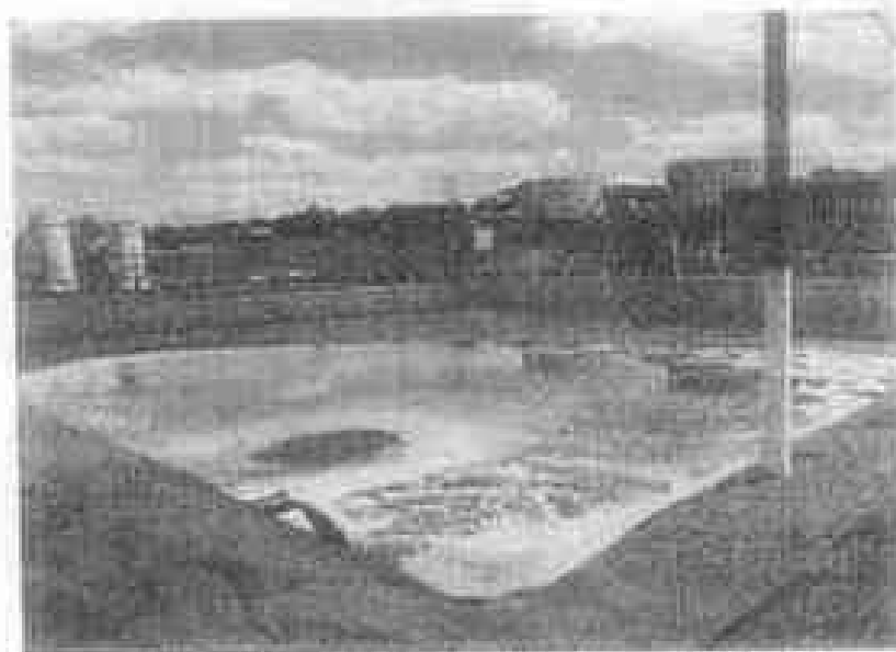
Figura 1 - Vista parcial do Reservatório Indústria / Vinhaça 2.
