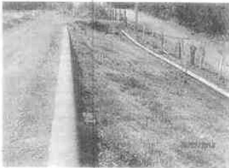
Figura 2 - Vista parcial de trecho externo da reservatório Água Servida 2.
