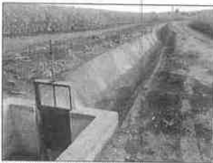
Figura 01 Canal de Várzea com Revestimento.
