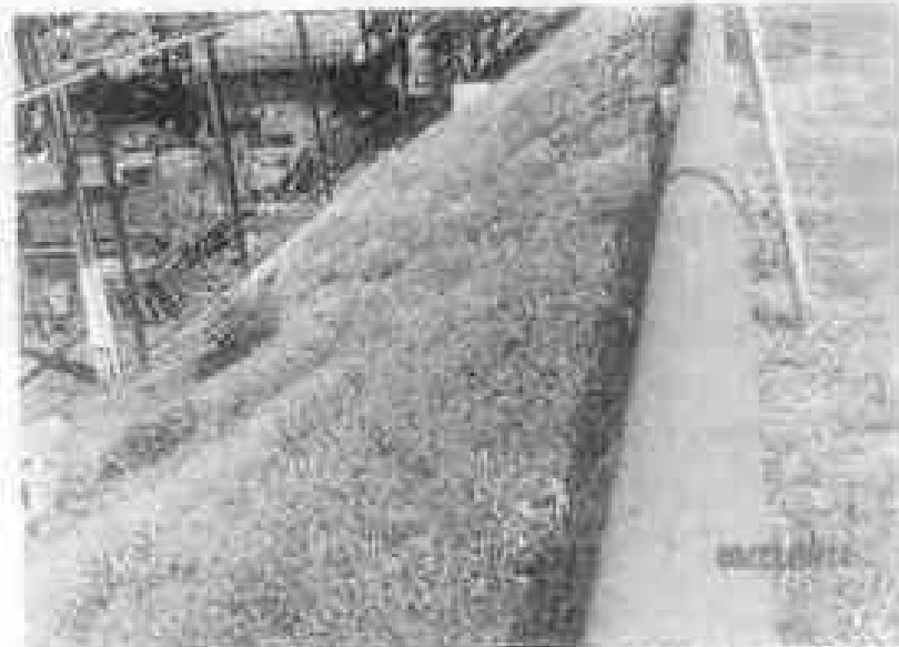
Figura 3 - Vista parcial do talude externo da Encosta da Indústrias / Visões 2.
