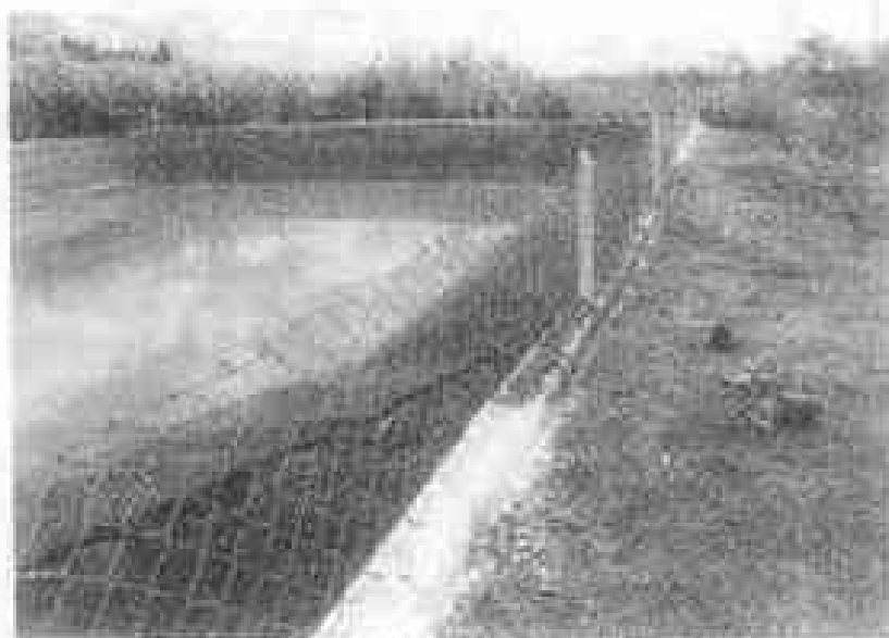
Figura 1 – Vista parcial do Reservatório Sifão do Godoi.
