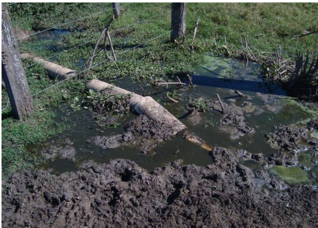
Foto 13: Início da canalização danificada para condução do efluente líquido tratado. Fonte: SUPRAM TMAP, 2013.
