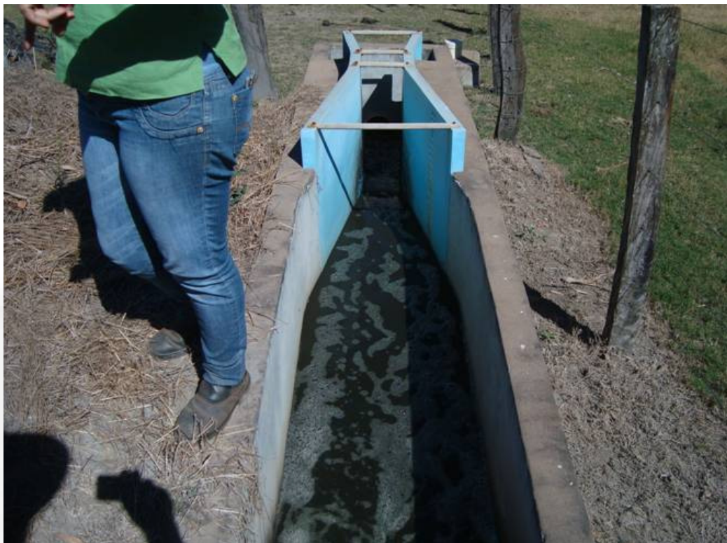
Foto 12: Medidor de vazão da saída da ETE em direção a canalização das curvas de nível. Fonte: SUPRAM TMAP, 2013.
