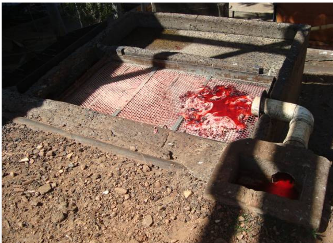
Foto 06: Local onde ocorre a chegada da linha vermelha e início do gradeamento. Fonte: SUPRAM TMAP, 2013.
