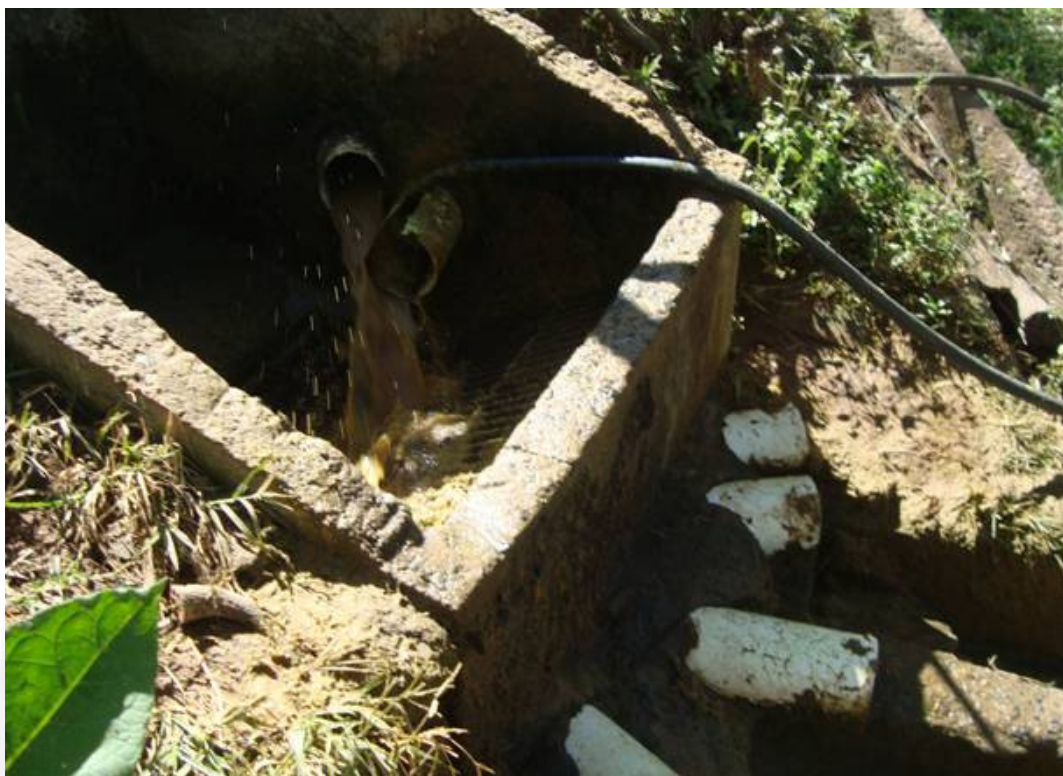
Foto 03: Chegada do efluente da linha verde. Nota-se esterco ao entorno da caixa de passagem. Fonte: SUPRAM TMAP, 2013.
