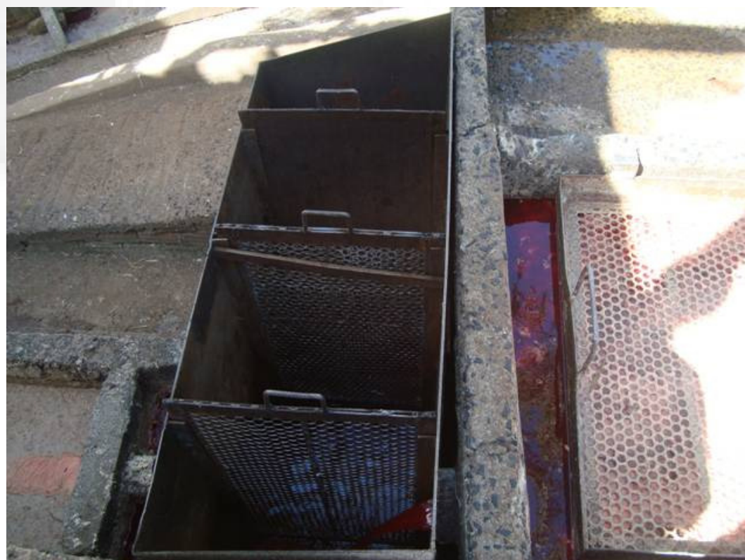
Foto 07: Gradeamento do efluente da linha vermelha Fonte: SUPRAM TMAP, 2013.
