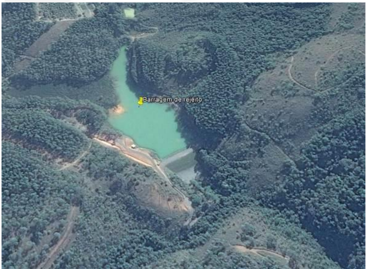
Figura 2: Barragem de rejeito.
