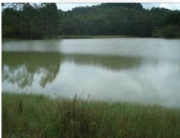
Foto 09. Vista parcial da barragem de rejeito.
