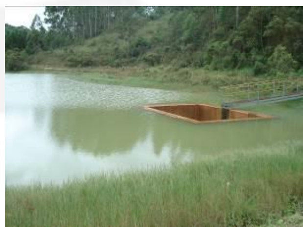
Foto 10. Vertedouro (tulipa retangular).
