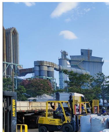
Foto 02: Sistema de despoeiramento do forno.
