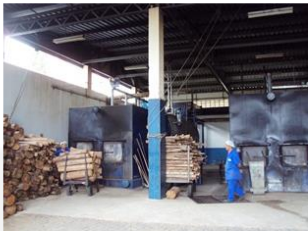
Foto 06. Caldeira utilizada para produção de vapor
