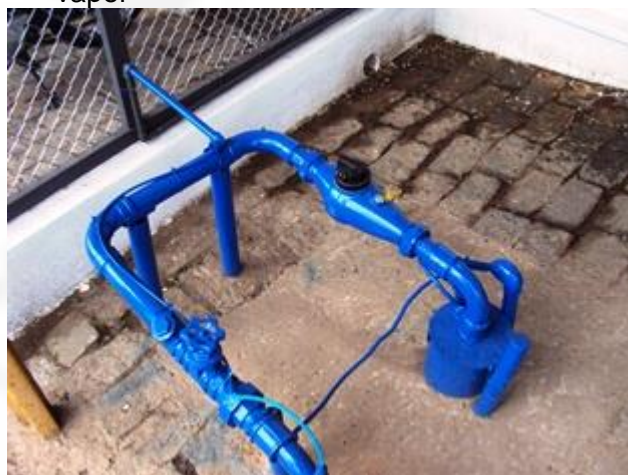
Foto 08. Poço tubular com hidrômetro instalado.
