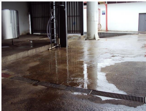
Foto 02. Área interna da empresa e sistema de drenagem pluvial
