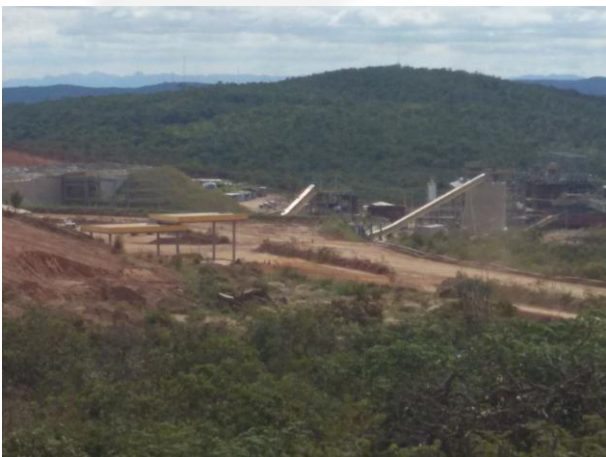
Foto 01 – Vista da Planta Hidrometalúrgica
