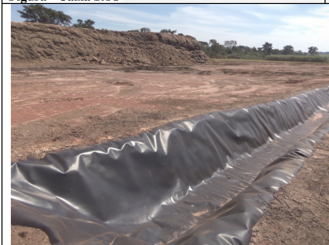
Figura - Sistema de Drenagem - pátio de bagaço de cana
