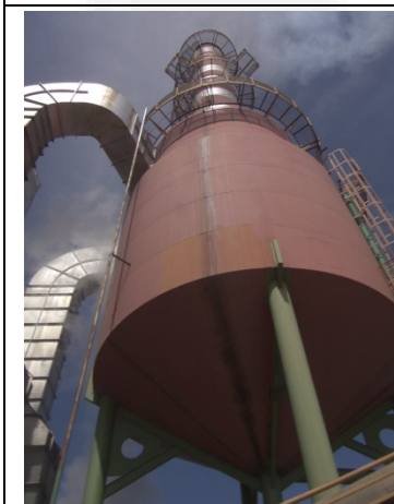
Figura - Multiciclones - Sistema de controle de poluição atmosférica
