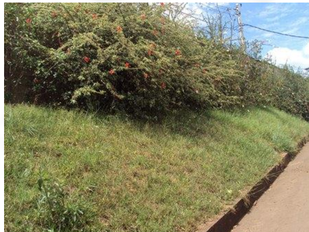
Foto 08. Sistema de drenagem pluvial
