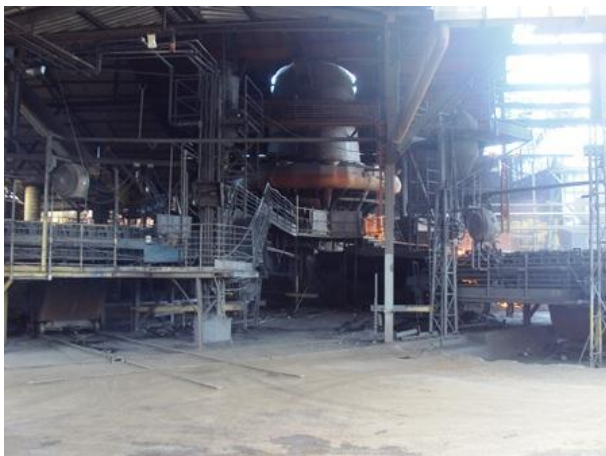
Foto 05. Local de instalação do sistema de metalurgia da panela
