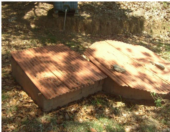
Foto 6: Estação de tratamento de efluentes
