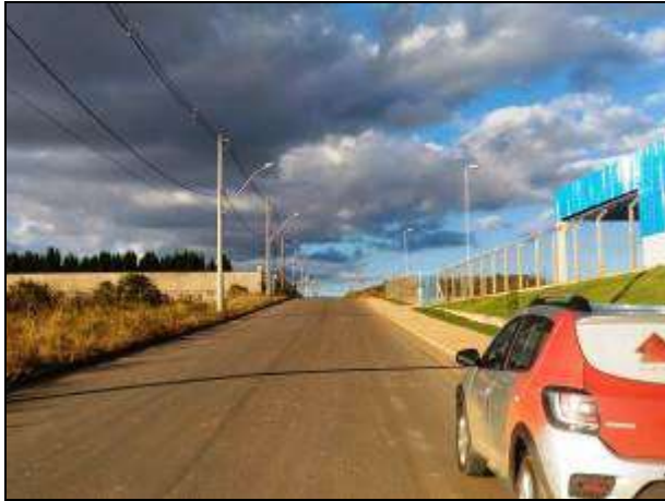
FOTO 01 – Área destinada à fase 1 do distrito com infraestrutura instalada e concluída.
