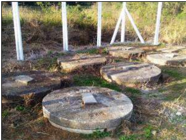
FOTO 03 – Sistema de tratamento de efluentes sanitários da fase 1 do empreendimento.
