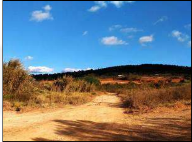
FOTO 02 – Área destinada à fase 2 do distrito com abertura das vias e infraestrutura inacabada.
