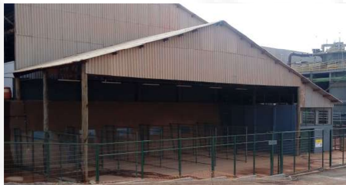
Galpão de armazenamento temporário de resíduos. À direita, o local para resíduos perigosos.
