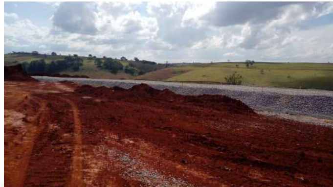
Área da pilha de estéril com sistema filtro-drenante ao fundo.
