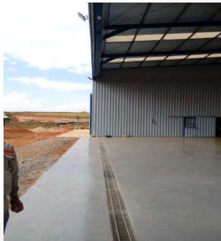
Área de manutenção com pista impermeabilizada e canaletas de contenção.
