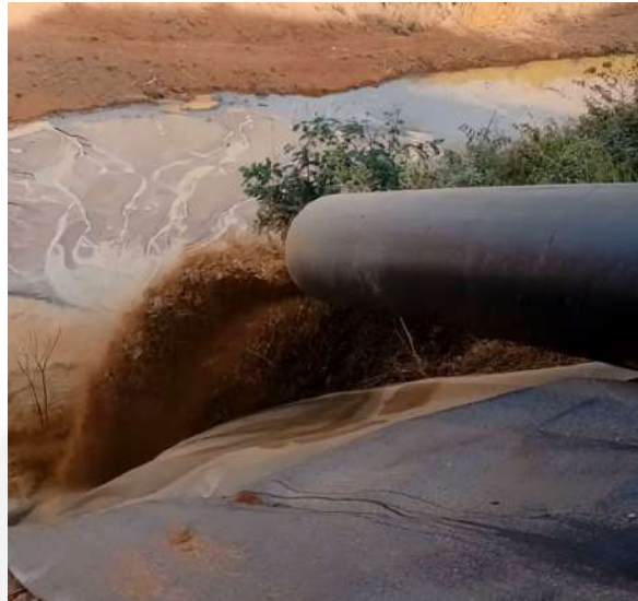
Ponto de lançamento dos rejeitos na Barragem Sabão I.
