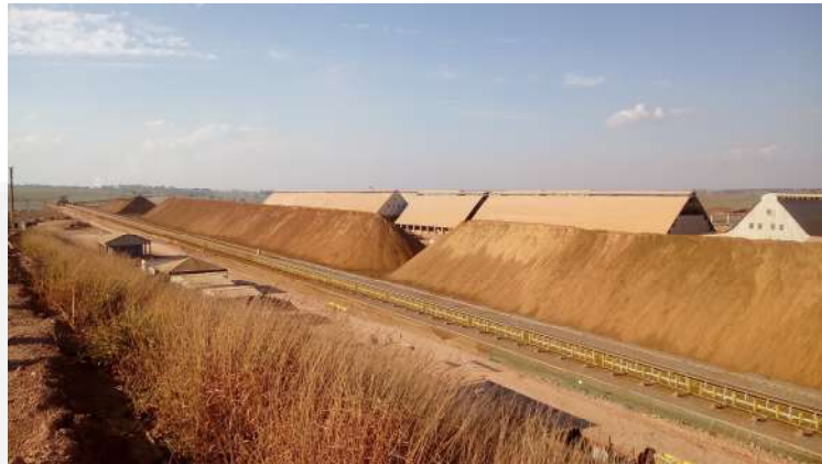
Pátio de homogeneização e de retomada (fase de comissionamento).
