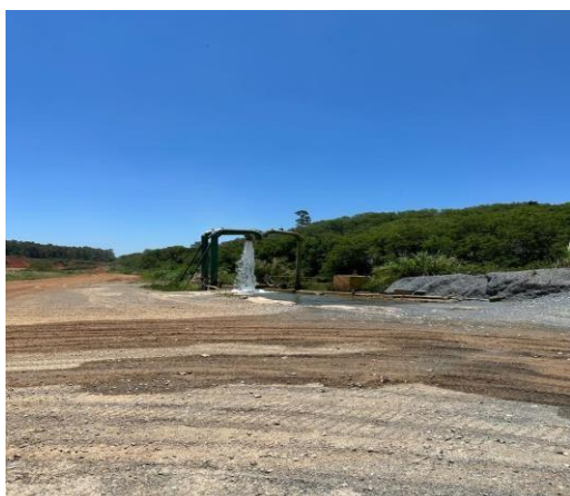
Foto 2 – Bombeamento água cava
