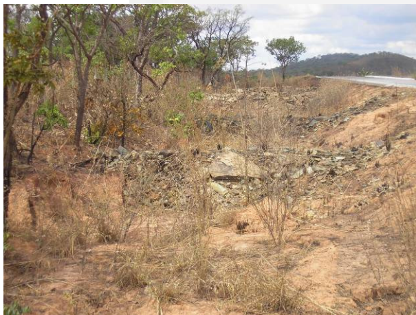
Foto 03. Diques de contenção para diminuição de processos erosivos
