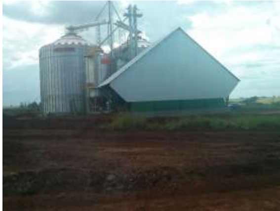
Foto 05. Silos de armazenamento de grãos
