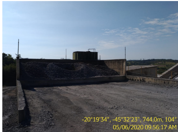
Foto 06. Aspersores instalados por toda empresa
