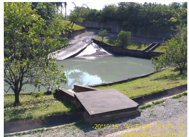
Foto 02. Bacia de contenção de água pluvial
