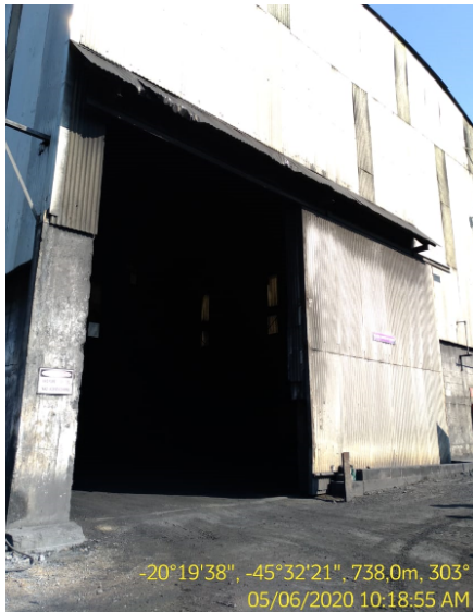
Foto 05. Galpão de armazenamento da moinha de carvão
