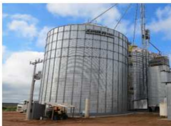
Foto 03. Unidade de armazenamento e beneficiamento do empreendimento
