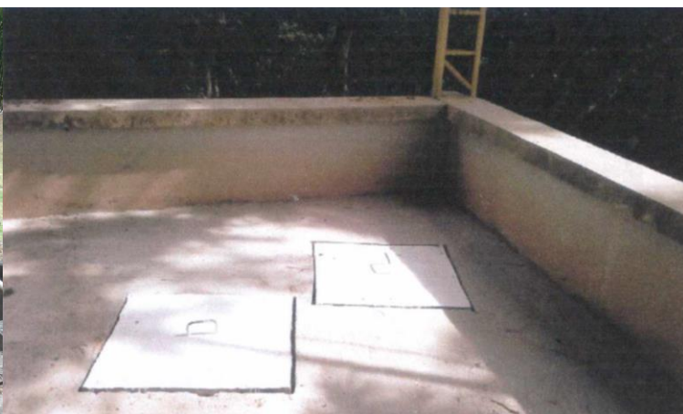
Foto 12: Caixa de passagem do sistema de tratamento de efluentes sanitários.
