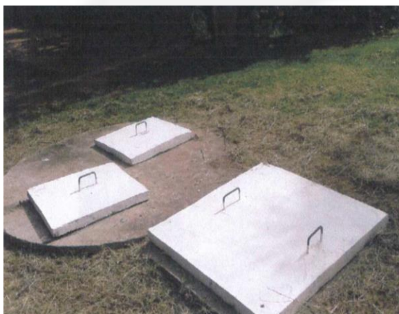
Foto 15: Caixa de passagem do sistema de tratamento de efluentes sanitários.
