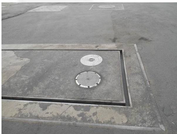
Foto 3: Área de descarga de combustíveis com canaleta.
