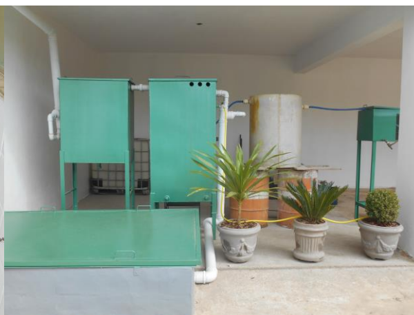
Foto 6: Caixa separadora de Água e Óleo.
