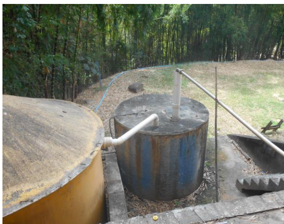
Foto 11: Sistema de tratamento de efluentes sanitários.
