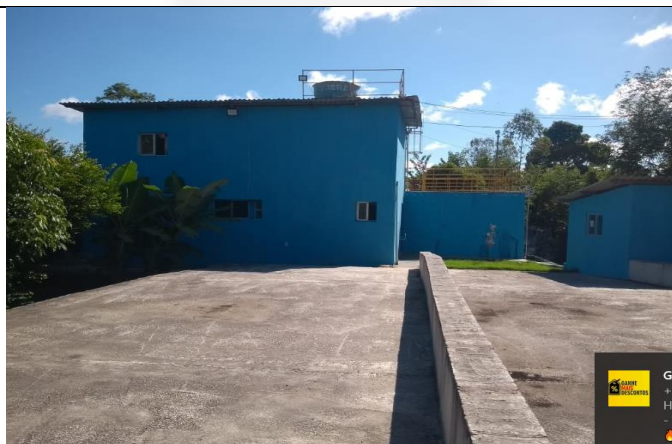
Foto 05. Estação de Tratamento de Água (ETA)
